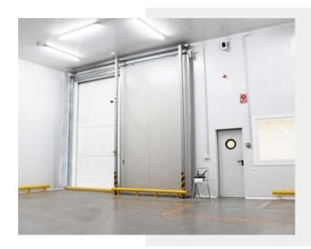
Las puertas correderas cortafuegos poseen una resistencia al fuego durante 60 minutos. Suelen permanecer abiertas, retenidas por un electroimán, hasta que, en caso de detección de incendios o un
